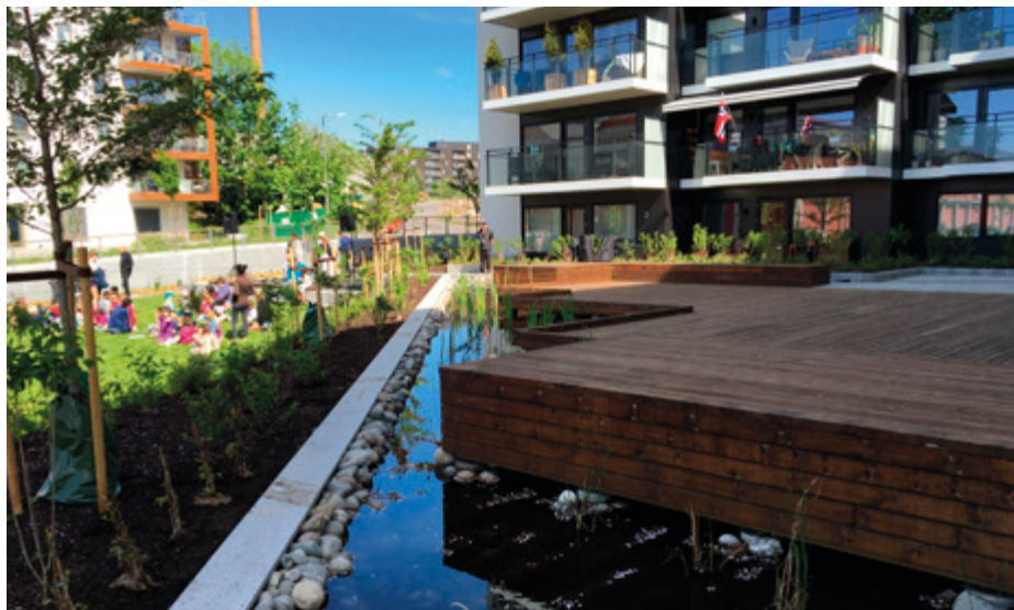
Åpent fordryningsbasseng for overvann ved Stålværksparken på Ensjo. Vannet føres til Hovinbekken, som er åpnet gjennom Ensjo.
