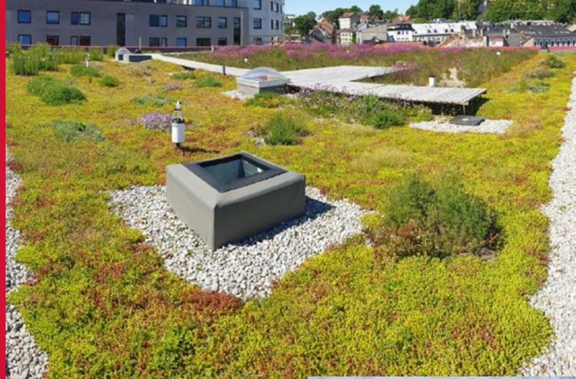
Nedbørmåler på det blågrønne taket på Vega scene Foto: NVE
