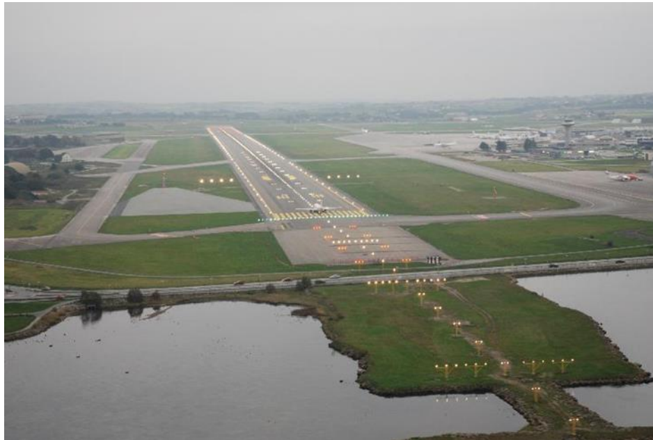
Pilotprosjekt Stavanger flyplass, Sola
