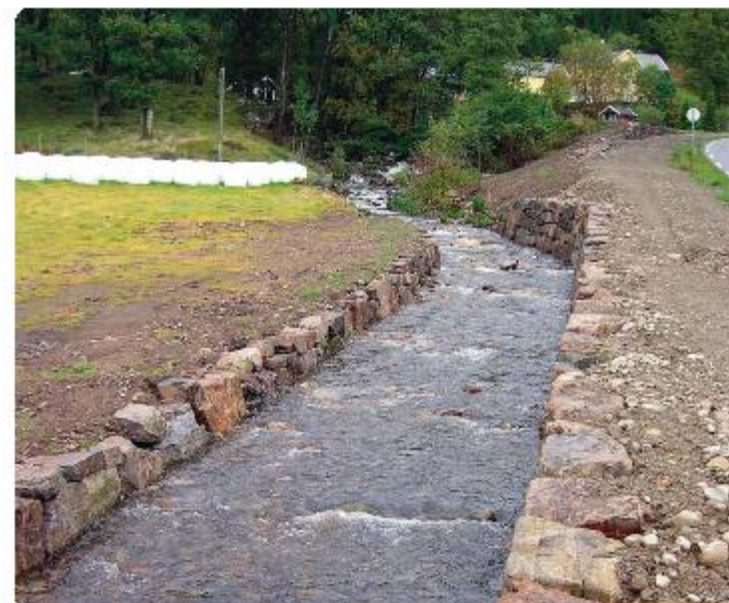
Naudyrnt forbygning og sikring av bekke- og elveløp må gjerast på ei fagleg forvarleg måte for å unngå skadelege bifellektar. Utretting løp fører ofte til at vatnet får stor fart og kan bety graving lenger nede i vassdraget. Dyrking heilt inntil bekkeløp er ulovleg. Bilete syner korleis slike tiltak ikkje skal gjerast. Foto: Trond Enk Børnesen.
