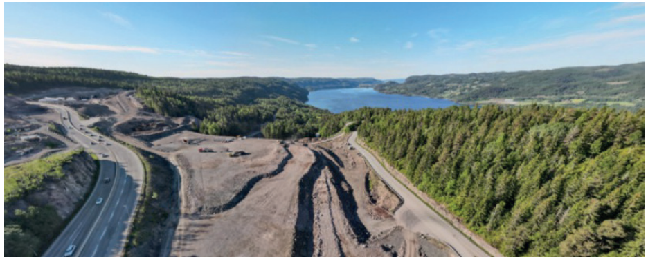
Dronefoto av sprengsteinsdeponiet i Nordlandsdalen (Holsfjorden i bakgrunnen).
